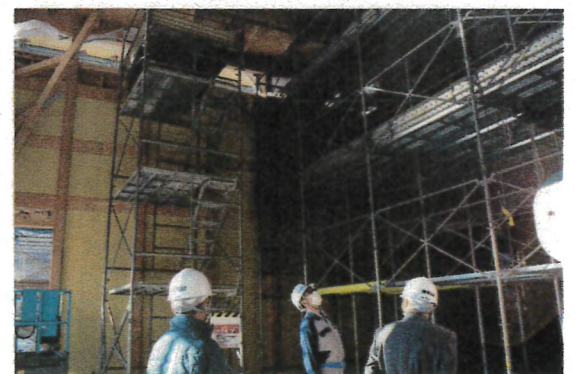
多目的ホール建設現場視察の様子
